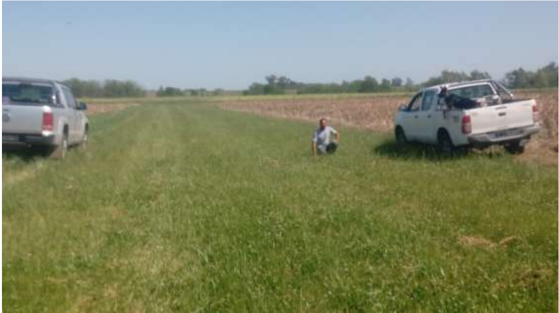
Foto 4; Cap. Sarmiento, Desagüe vegetado parabólico apto para recibir excedentes hídricos
